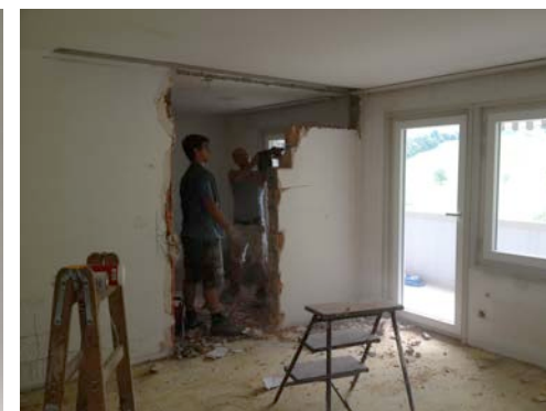
Ausbruch der Küchenwand
