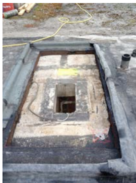
Dachöffnung - es wird jede einzelne Küchenabluft direkt ins Freie geführt
