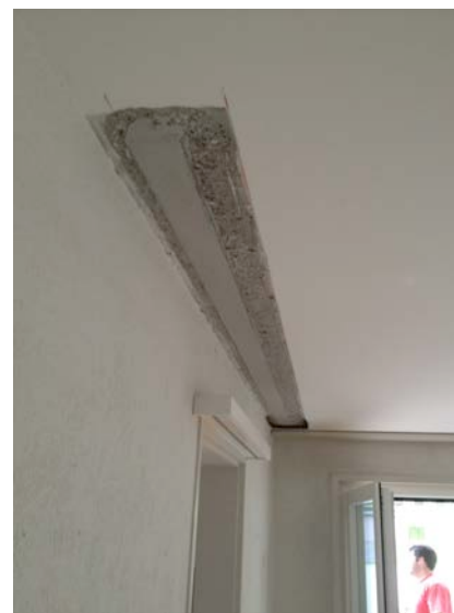
Spezialarmierung statt Eisenträger
