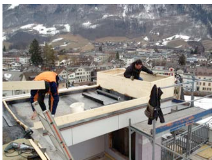
Dachöffnung - es wird jede einzelne Küchenabluft direkt ins Freie geführt
